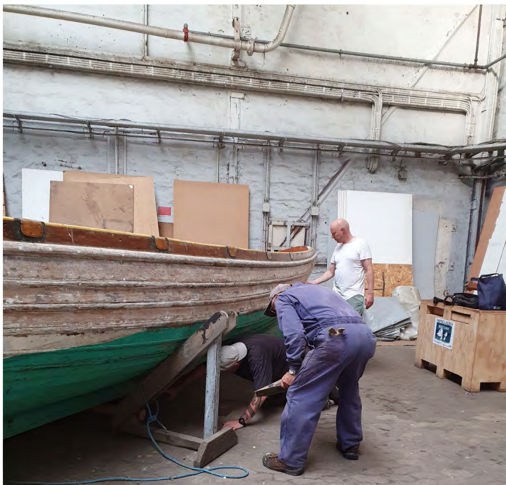
Peter Welsh, Jan Ibenhard og Klaus Broch igang med at skrabe og undersøge bordene
